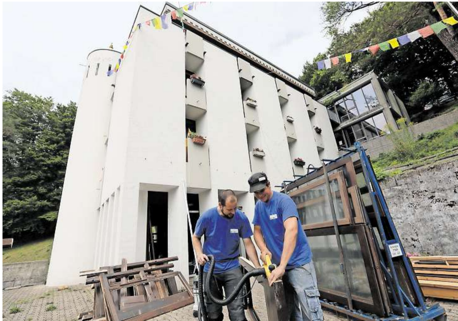
Die neuen sehen aus wie die alten: Die Fenster im Tibet-Institut bleiben optisch gleich, darum kümmerte sich der Denkmalschutz.
