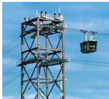
In Brest in Frankreich realisierte BMF eine Pendelbahn, welche die Fahrbahnen übereinander führt.
