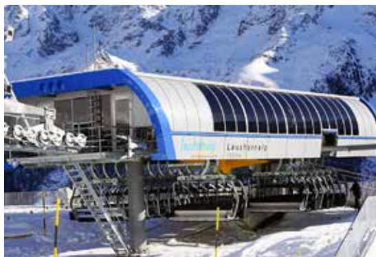
Die neue 6er-Sesselbahn auf der Lauchernalp ist mit einer Stationsgaragierung ausgerüstet.
