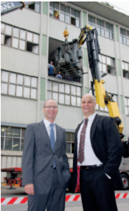
Markus Frauchiger (Geschäftsleiter) und Thorsten Domke (Verkaufsleiter, beide RCM-Estech AG) gehen davon aus, dass die neue Gebäudestruktur und der optimierte Fertigungsfluss die Produktivität steigert.
