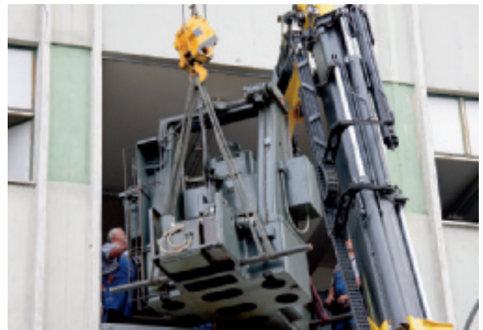
Im Bild ein SIP-Lehrenbohrwerk, das mit zwei Kränen synchron aus dem alten Gebäude gehoben wird.
